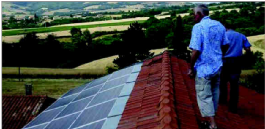
■ La centrale villageoise photovoltaïque des Haies.
